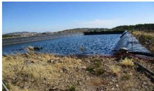
Figuras 7 e 8. Charca impermeabilizada utilizada para sistema de rega de amendoal em 14.10.2024, a cerca de 90-95% da sua capacidade (esq.) e a mesma charca em 13.10.2025, a cerca de 60% da capacidade máxima (dir.), Castelo Branco – Mogadouro Fotos por: Miguel Martins
