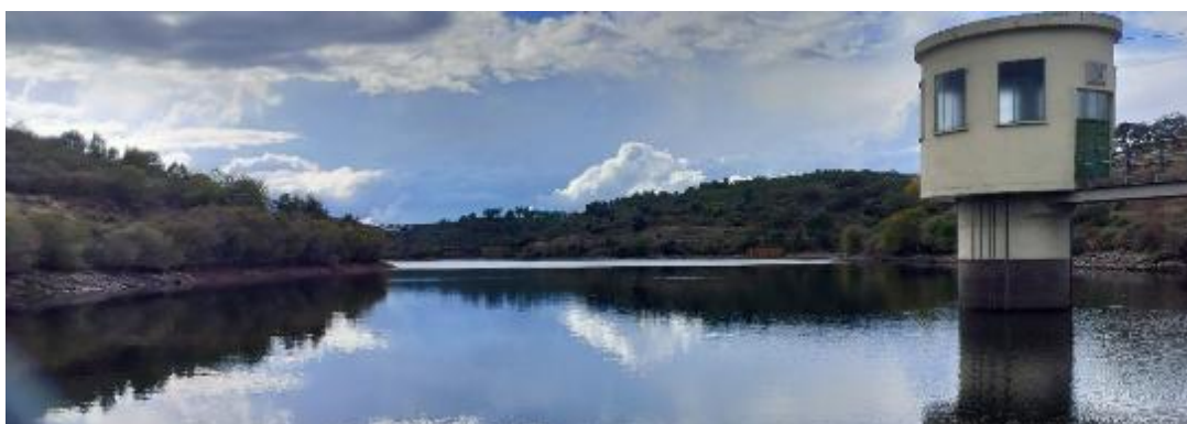
Figura 4. Barragem de Penas Roias com o nível a cerca de 85%, 16.10.2024, Mogadouro
