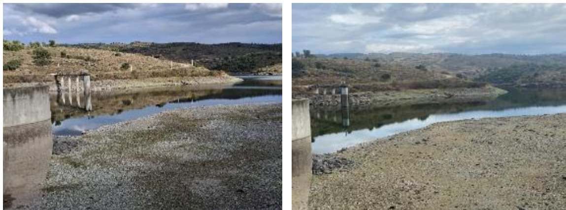
Figuras 11 e 12. Barragem de Vale de Madeiro em 2024 (esq.), com NPA de 59,24% e em 2025 (dir.), com NPA de 68,09%, Mirandela
