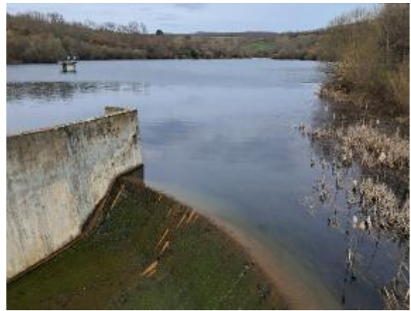
Figura 15. Barragem de Prada, 20.03.2026, Vinhais
