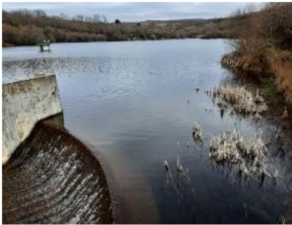
Figura 14. Barragem de Prada, 17.03.2025, Vinhais Fotos por: Anabela Coimbra
