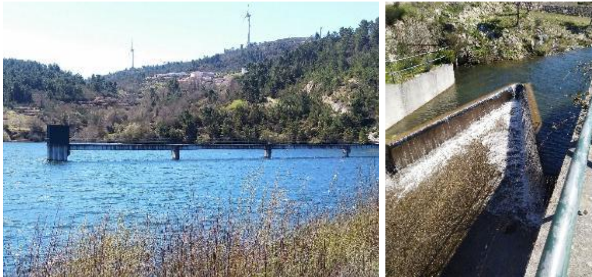
Figuras 20 e 21. Barragem de Temilobos, 17.03.2026, Armamar
