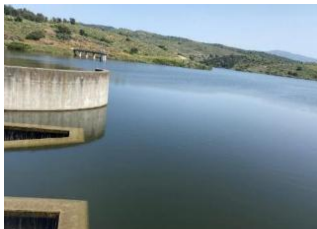
Figuras 15 e 16. Barragem de Vale de Madeiro, Mirandela
