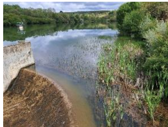
Figura 8. Barragem de Prada, 14.05.2026, Vinhais
