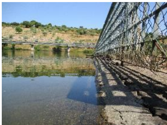
Figura 16. Barragem de Penas Roidas, 16.06.2025, Mogadouro
