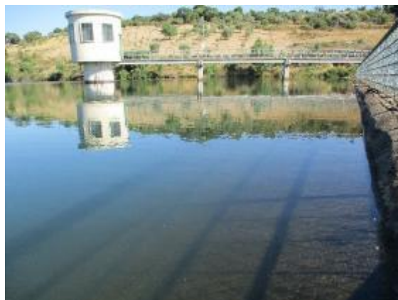
Figura 17. Barragem de Penas Roidas, 15.06.2026, Mogadouro
