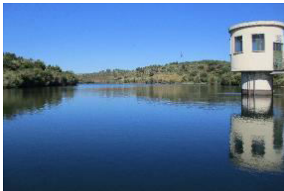
Figura 15. Barragem de Penas Roias, 15.07.2025, Mogadouro
