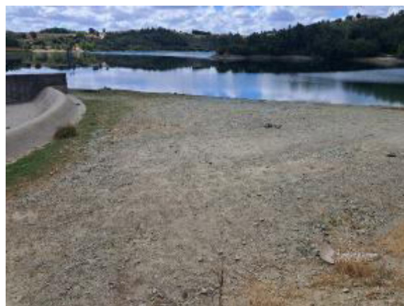
Figura 14. Barragem de Prada, 15.07.2026, Prada – Vinhais
