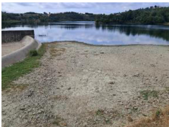
Figura 13. Barragem de Prada, 11.07.2025, Prada – Vinhais Fotos por: Anabela Coimbra
