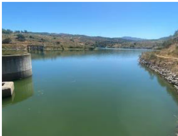
Figura 19. Barragem de Vale de Madeiro, 2025, Mirandela
