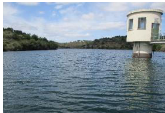
Figura 16. Barragem de Penas Roias, 13.07.2026, Mogadouro
