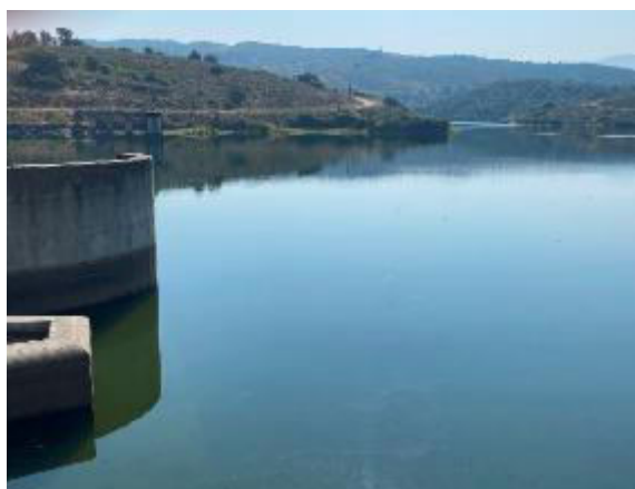
Figura 21. Barragem da Eucísia, 2025, Alfândega da Fé
