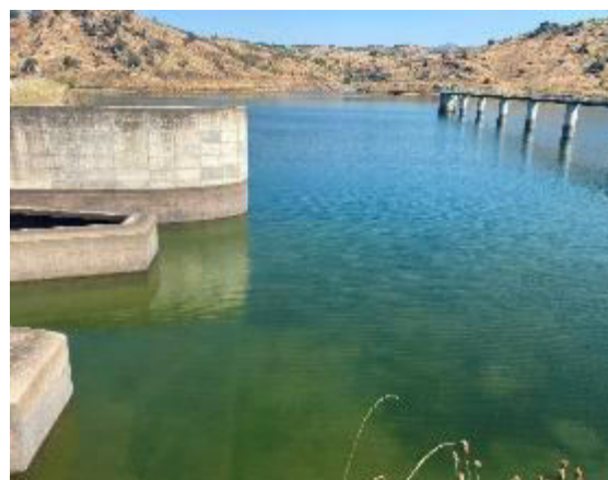
Figura 22. Barragem da Eucísia, 2026, Alfândega da Fé
