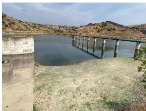
Figura 33. Barragem de Vale Madeiro, agosto de 2026, Mirandela
