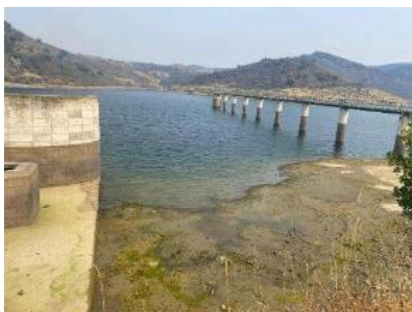
Figura 32. Barragem de Vale Madeiro, agosto de 2025, Mirandela
