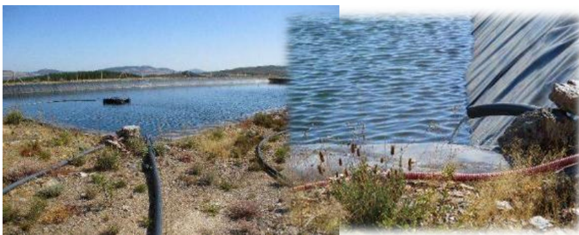
Figuras 16 e 17. Charca em Castelo Branco, em 10.08.2026, a pelo menos 80% de capacidade, com pormenor de mangueira de adução, cujo abastecimento se faz mecanicamente através de furo artesiano (lençol freático), Mogadouro
