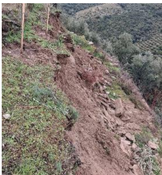
Figuras 15 e 16. Derrocadas de encosta e de muro de pedra posta, Tabuaço
